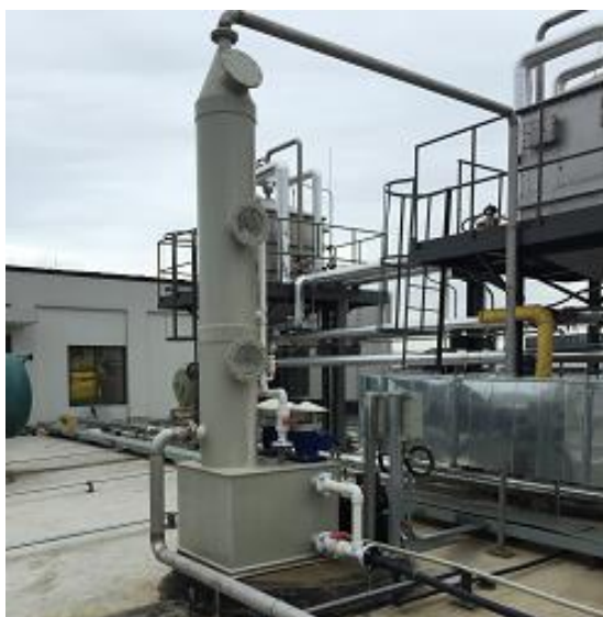
树脂吸附前喷淋塔
